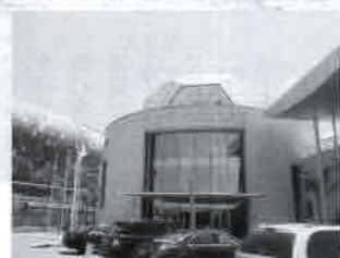
▲ヨハネスブルグ、サッカーシティ・スタジアムのそばに完成した南ア・サッカー協会本部
